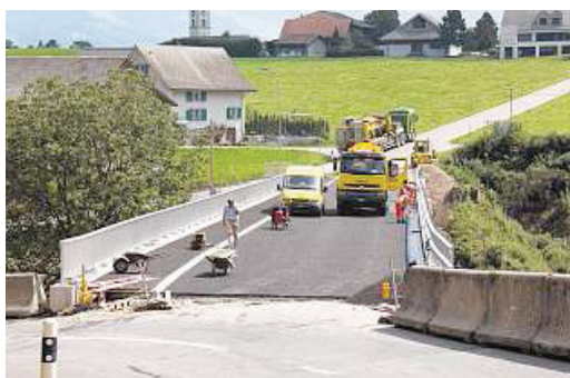
Fertig asphaltiert: Ganz abgeschlossen sind die Bauarbeiten an der Brücke über den Hofmühlebach aber noch nicht. Foto: Adrian Huber
